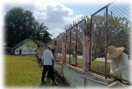
外壁塗装ボランティアの様子
