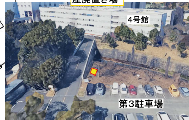
スロープ脇 産廃置き場
