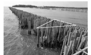
図 3：タイ湾 Khok Kham 村に設置されている竹柵 (注)鈴木ほか(2016)より
