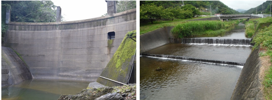
図5 調査河川に存在する河川横断構造物の例（左：高さ 25m のダム、右：高さ 1m 以下の落差工）
