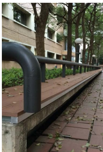
<外構石ベンチ改修工事(後楽園)>
