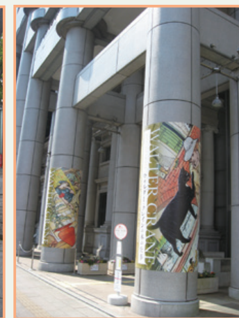
千葉市美術館が入っている建物の外観
