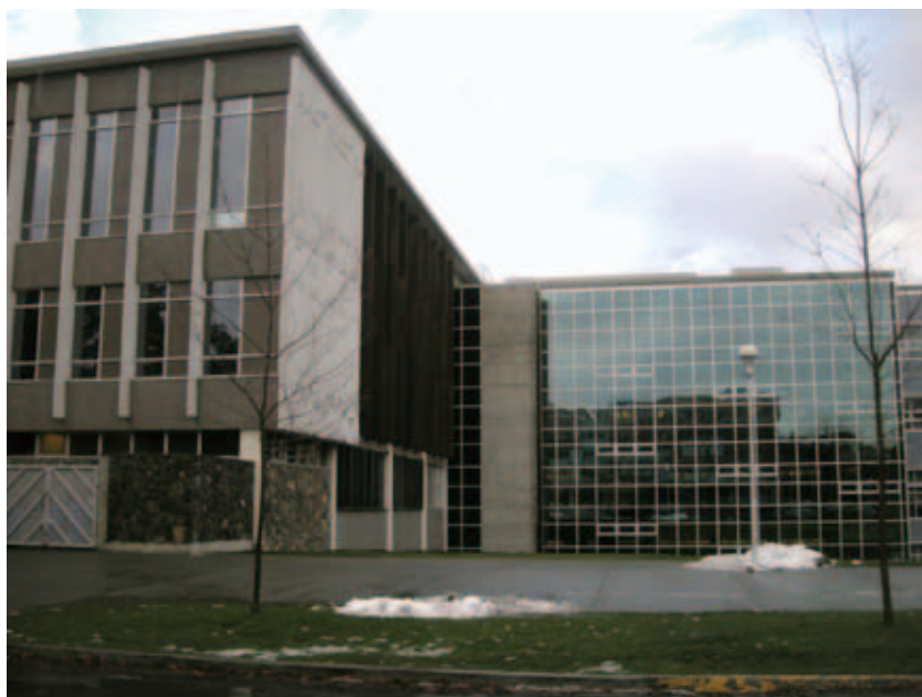
UVic, McPherson Libraryの増築箇所(ガラス張りの部分)
