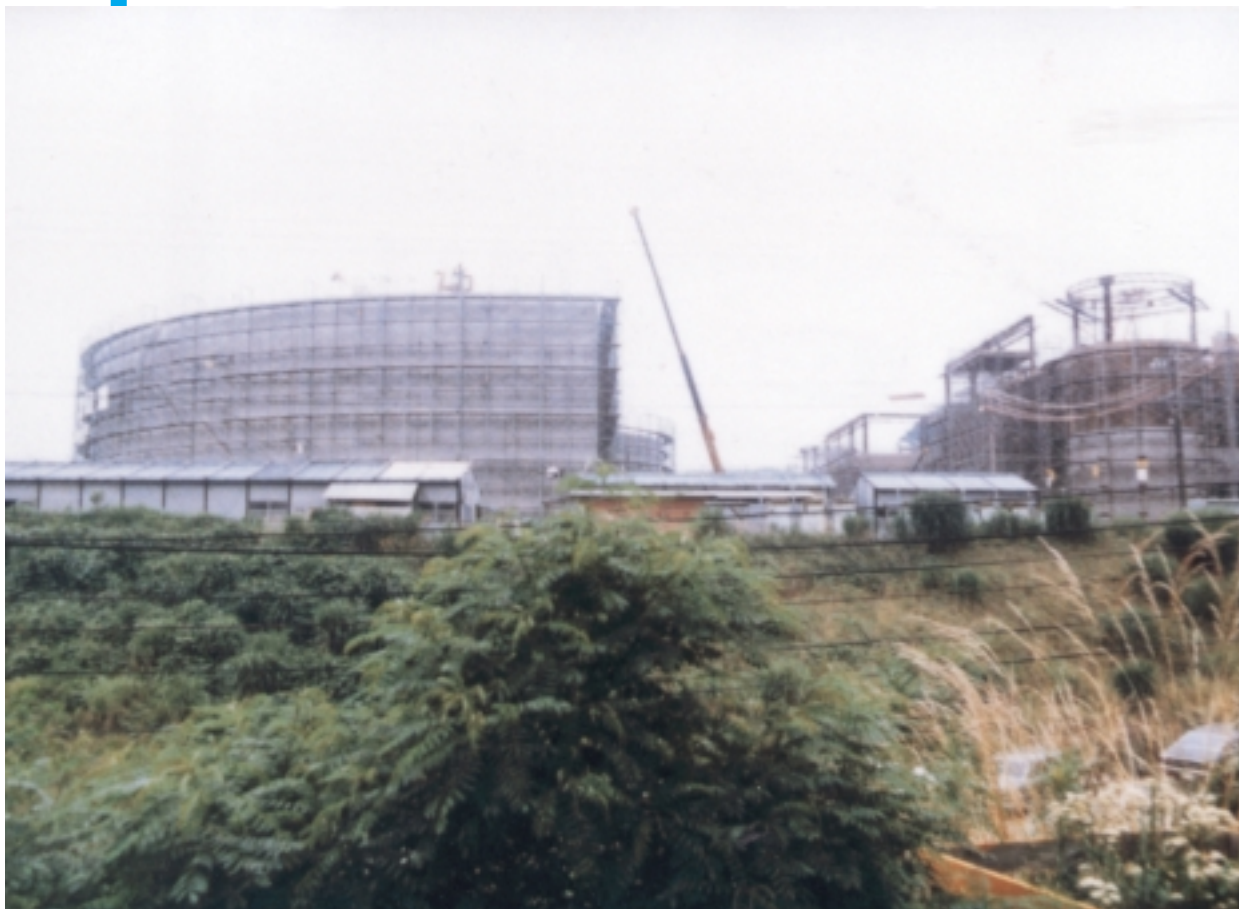
建築中のクレセント・ホール
