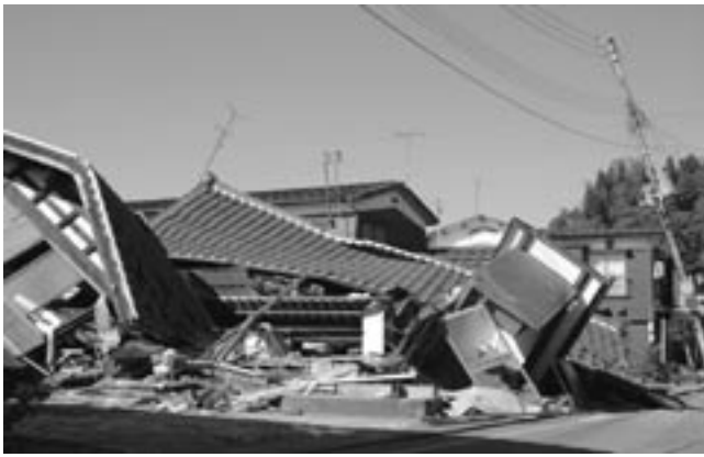
倒壊した家屋＝小千谷市
