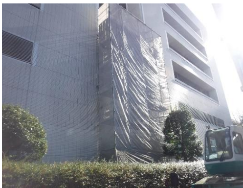
外部足場イメージ写真
