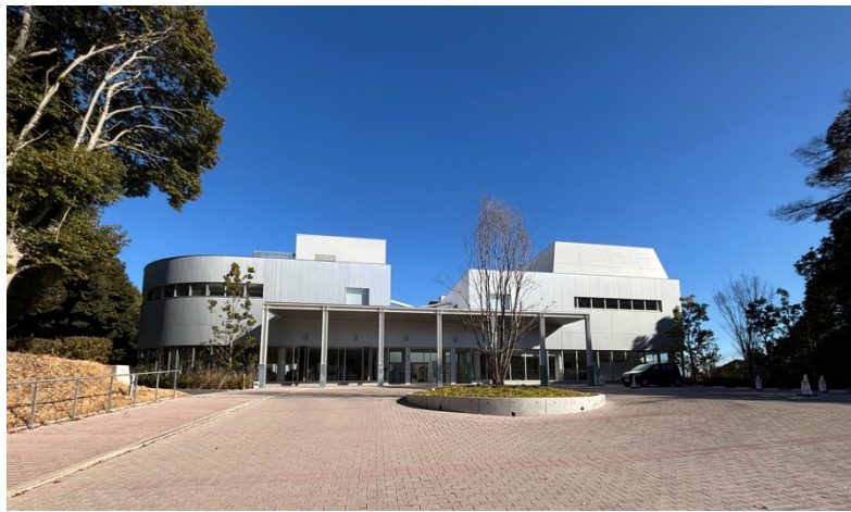
① イータエントランス外観
