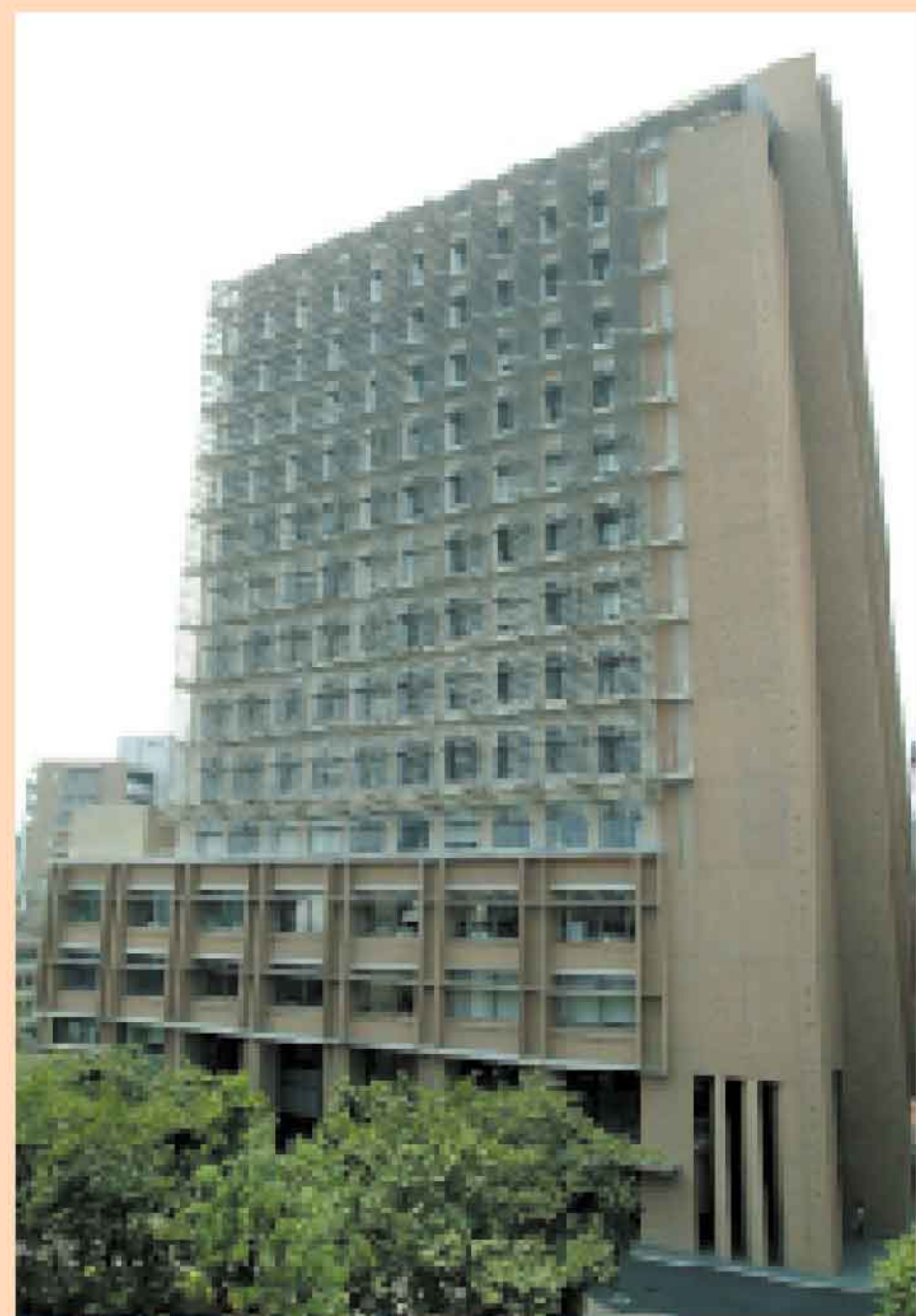
理工学部新3号館 14階建て、地下2階。4月竣工した。
